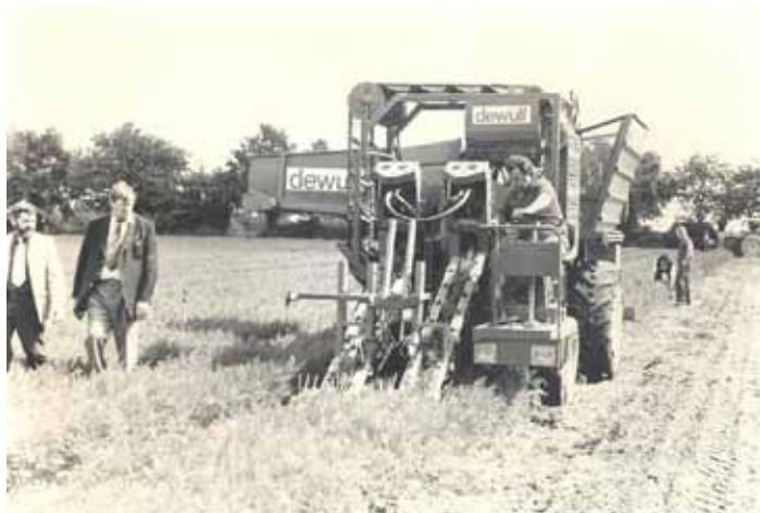
1970: una de las primeras arrancadoras de zanahorias de levantamiento superior autopropulsadas
